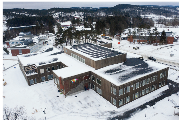
Det er montert solcellepaneler på deler av taket.
